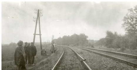
Foto van de sabotage bij Twello, ter hoogte van km. 11.8; 23-8-1942. (Utrechts Archief, Beeldbank, Deelcollectie Nederlandse Spoorwegen, 023 Apeldoorn – Deventer, catalogusnummer 807702)
