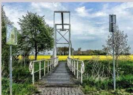
Noaberbrug Bad Nieuweschans
